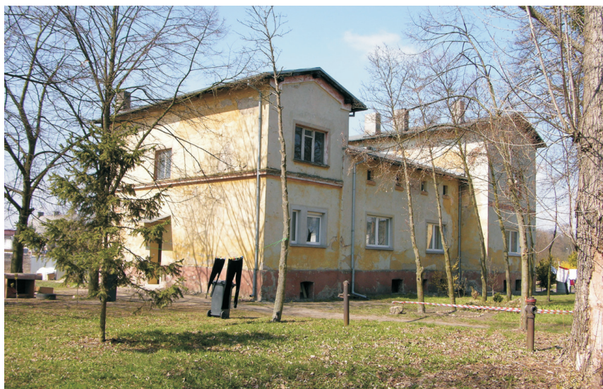
Budynek kolonii karnej w Targowej Górcie. Widok od południowego wschodu, 2012. Ze zbiorów autora
