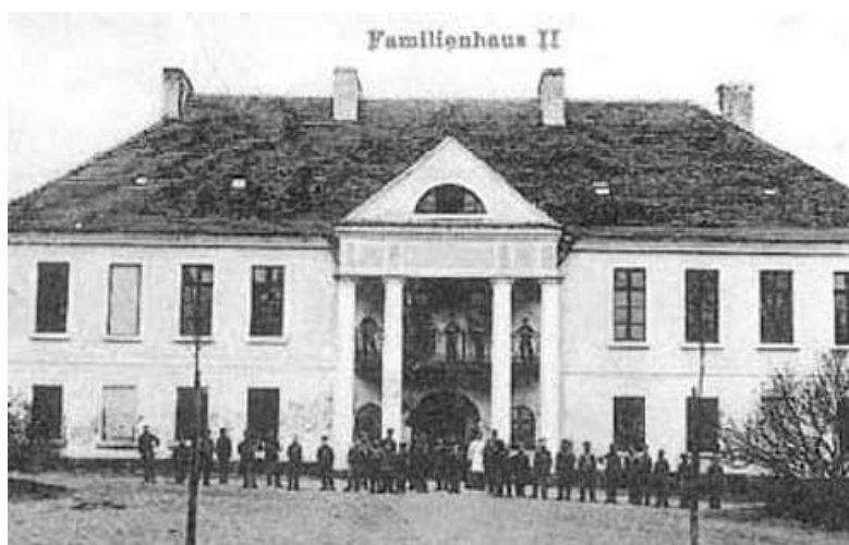
Budynek Zakładu Wychowawczego (pocztówka z ok. 1912)
