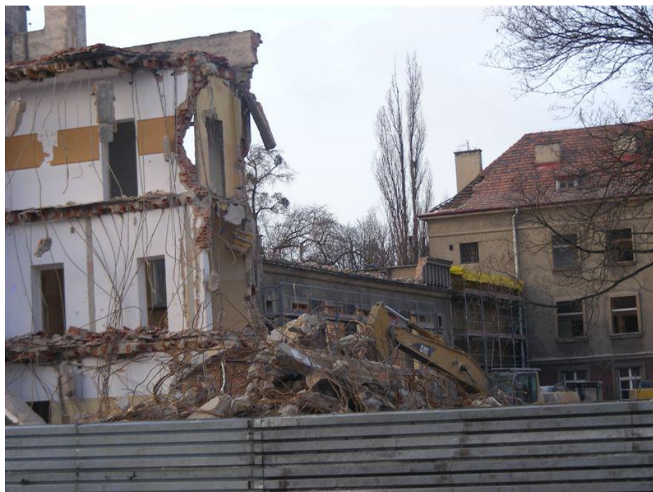
Szkoła podczas rozbiórki 2008
