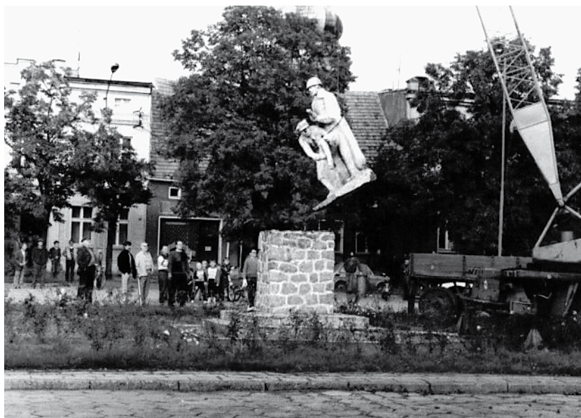
Demontaż pomnika we wrześniu 1990 r.
